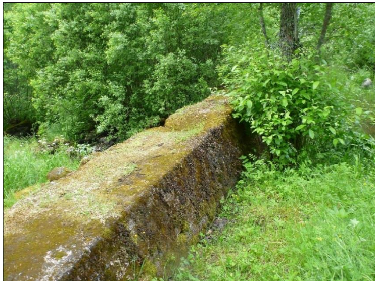
Myllypadon uudempia betonisia rakenteita. Kuvattu lounaaseen.
